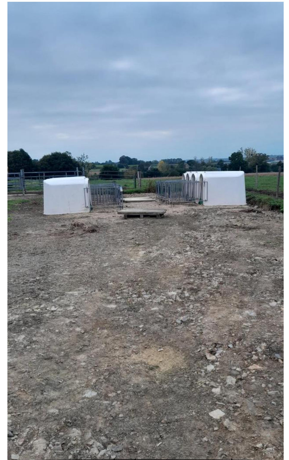
Terrassement et déplacement des niches individuelles
